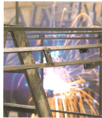
Geschweißter Stahlprofilrahmen des Hytermobils.
